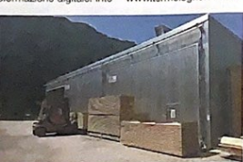
Impianti per il risparmio energetico
