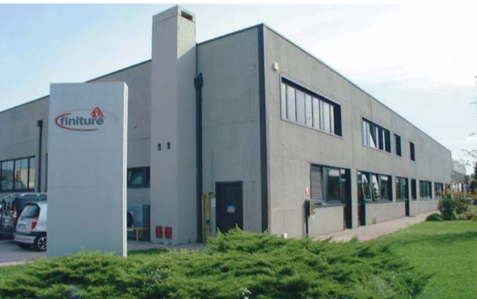
Lo stabilimento Finiture a Saonara (Padova).
